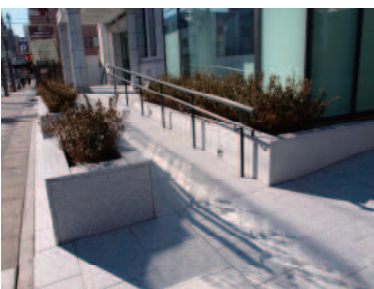
【正面玄関に設置したスロープ】
