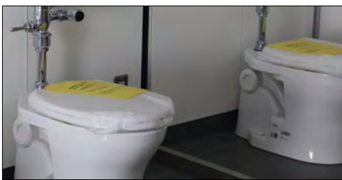
▲工事中のトイレ
